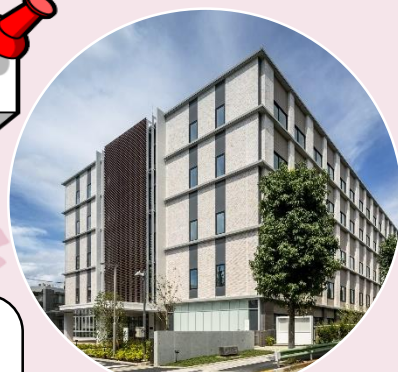
(庁舎入口付近)
